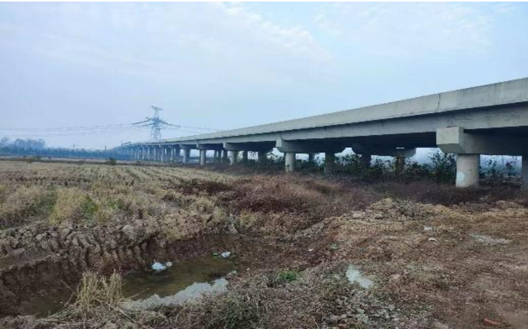
图 2.1-2 跨宁西铁路立交桥全景图
